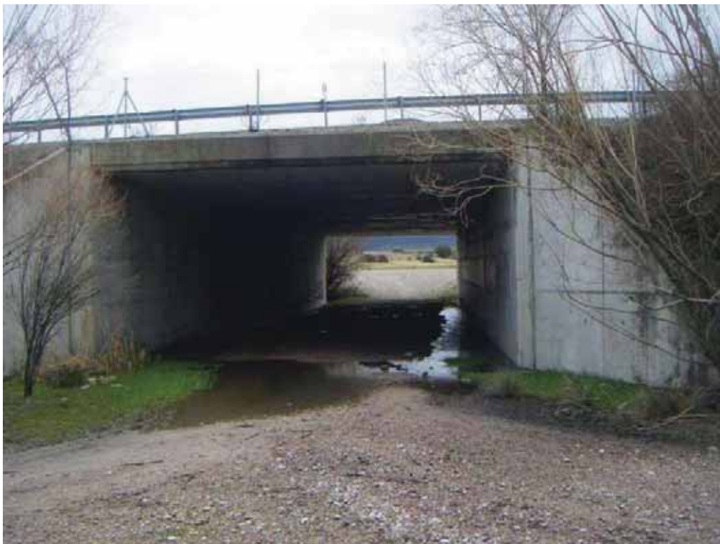
FOTOGRAFÍA 29. Paso subterráneo para vehículos y drenaje bajo la autopista AP-61 correspondiente a la Vereda del Retamar
